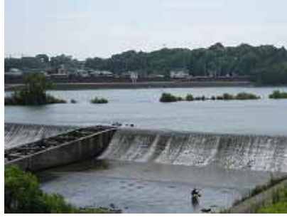
山国川対岸(上毛町)〔旧中津地区〕から見た 大井手堰頭首工(三口浄水場を背景に入れた) の景色
