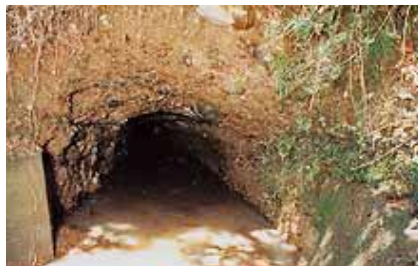
〔三光地区〕から見た 川平間歩(荒瀬水路跡) の景色
