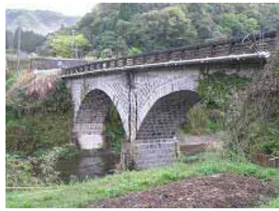
〔耶馬溪地区〕から見た 賀治耶橋（眼鏡橋） の景色
