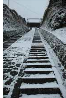
山国町草本 国道496号 (山国地区) から見た 教順寺の石段 の景色
