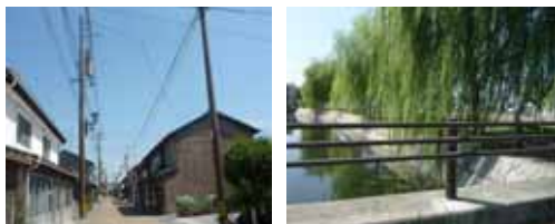
景観に配慮した電柱や防護柵の例
