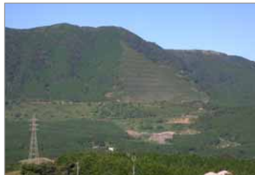
緑化により目立たないように配慮した例
