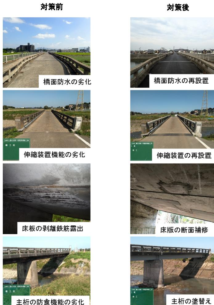
図-7 橋梁補修対策の事例写真
