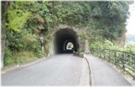
洞門隧道（本耶馬溪）
