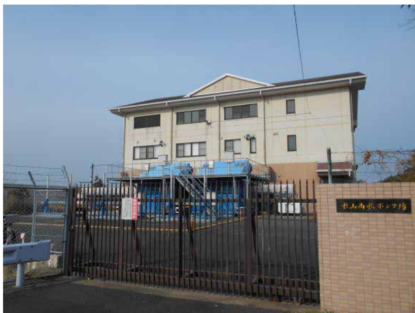
内水排除対策の推進(雨水ポンプ場)
