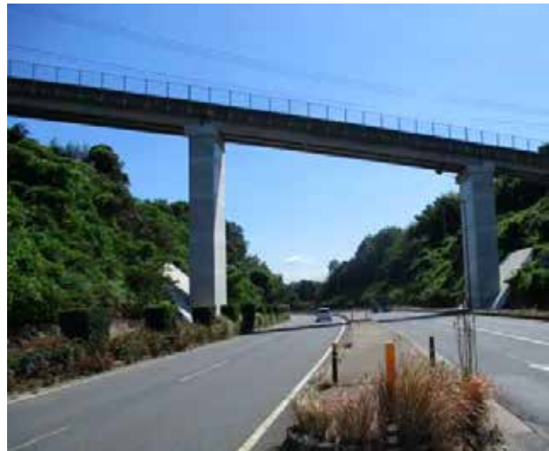
小平跨道橋 橋りょう長寿命化事業
