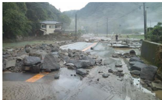
出典：平成 24 年九州北部豪雨災害中津市災害記録誌 流れてきた岩石土砂に埋もれた国道 212 号(宮園地区)
