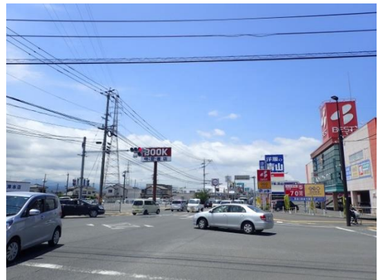
国道213号（下池永付近）
