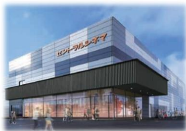
建設中の映画館（完成イメージ）
