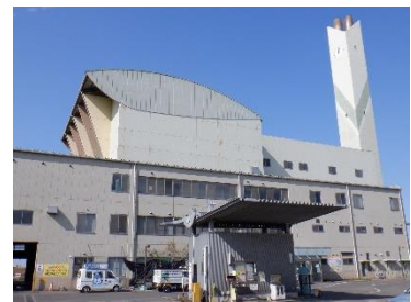
現ごみ処理施設 ※H11年稼働開始 (中津市クリーンプラザ)
