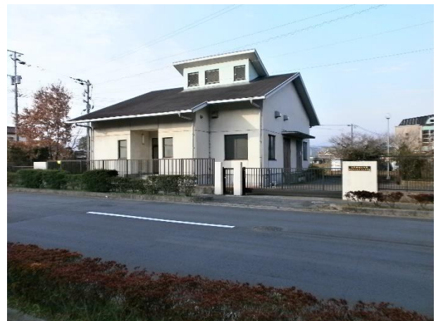
(三光佐知中継ポンプ場)
