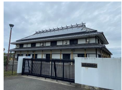
三光地区処理場
