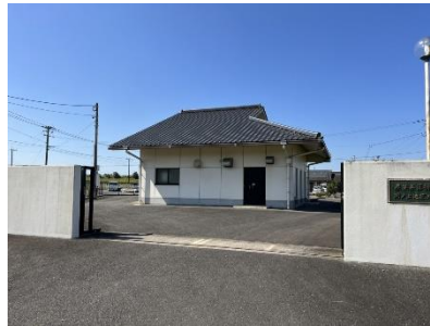
洞ノ上地区処理場
