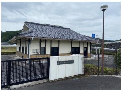
樋田浄化センター
