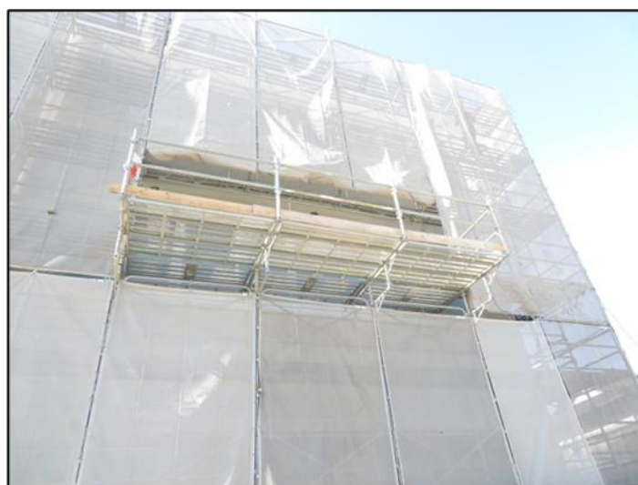
外部足場設置状況（手摺、幅木、落下防止網、壁繋ぎ等は適正に設置されている）
