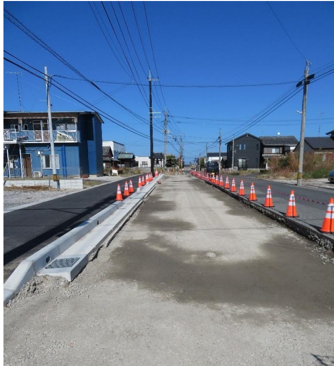
雨水枡・L型側溝設置、下層路盤状況（締固め状況は良好である）
