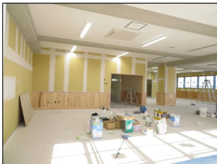
図書室内部仕上げ状況（木質系内装材の採用）
