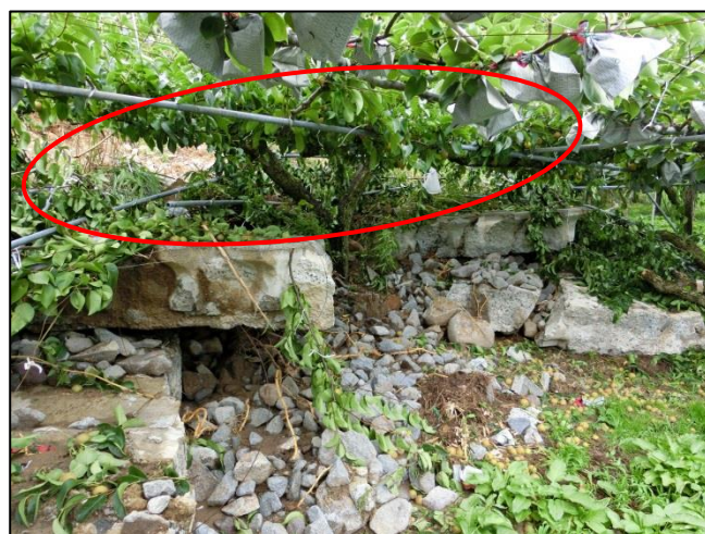
梨棚の被災状況（倒壊）
