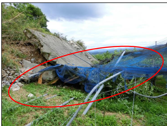
梨棚の被災状況（倒壊）
