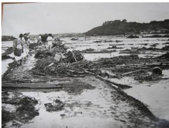
被災した田口地区の様子
