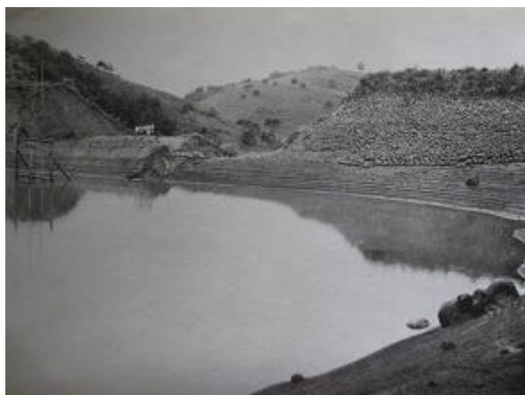
決壊した八面山大池
