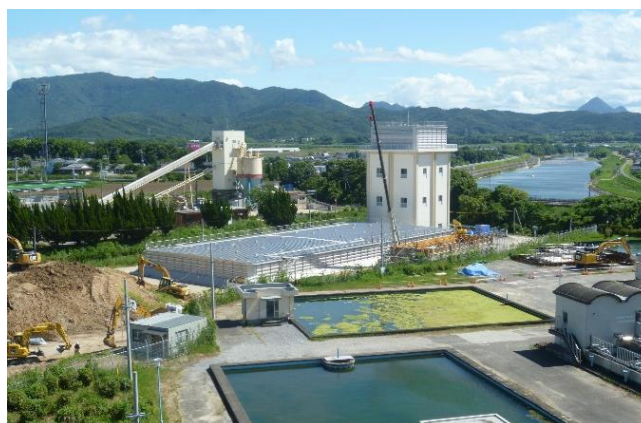
配水池増設工事
